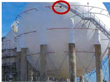
ภาพแสดงตำแหน่งรั้วที่เกาะกับท่อน้ำดับเพลิง
